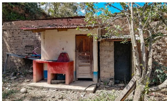
FOTOGRAFIA N° 2.6-78 Instalación en la vivienda de red de desagüe
