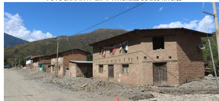
FOTOGRAFIA N° 2.6-6 Viviendas de dos niveles
