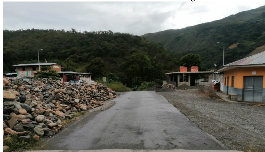
FOTOGRAFIA N° 2.6-16 Estado de conservación Regular de vías
