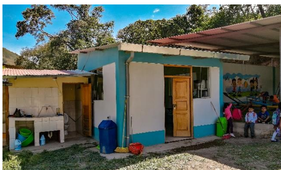
FOTOGRAFIA N° 2.6-25 Interior de Aulas FOTOGRAFIA N° 2.6-26 Bloque de Aulas y dirección FOTOGRAFIA N° 2.6-27 Bloque de Cocina
