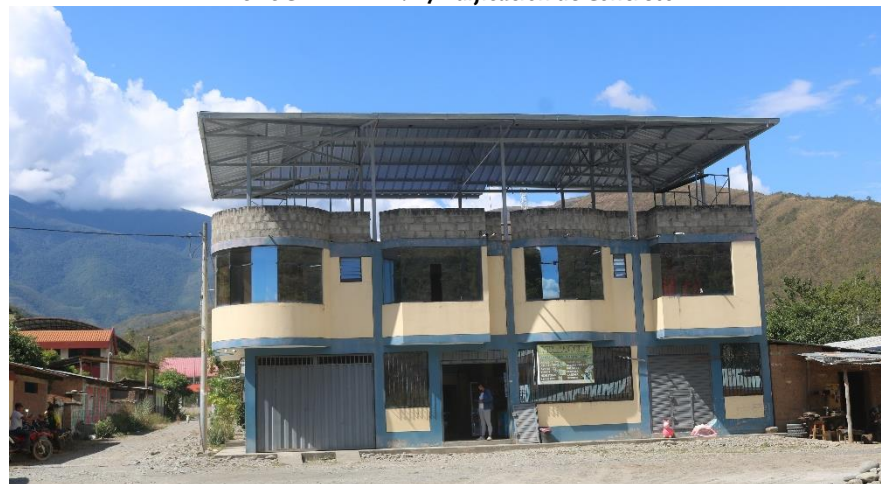
FOTOGRAFIA N° 2.6-7 Edificación de Concreto
