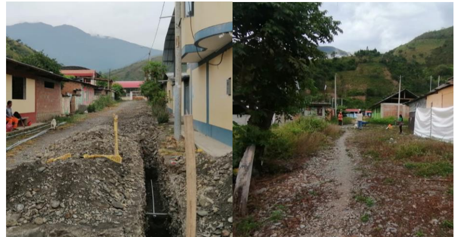
FOTOGRAFIA N° 2.6-13 Vía Local Vehicular y Peatonal
