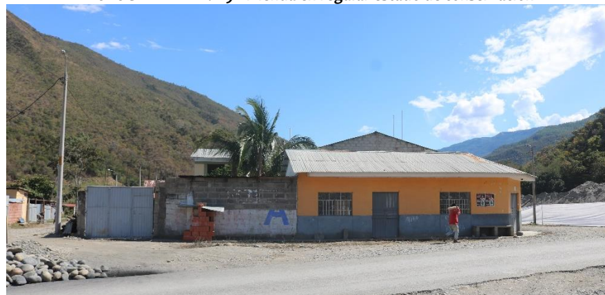
FOTOGRAFIA N° 2.6-9 Vivienda en regular estado de conservación
