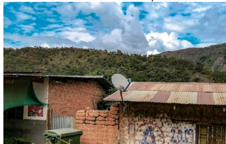
FOTOGRAFIA N° 2.6-81 Instalación típica de Cable
