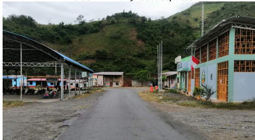
FOTOGRAFIA N° 2.6-15 Vía trocha afirmada
