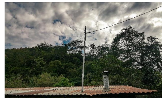
FOTOGRAFIA N° 2.6-79 Red de energía eléctrica del poblado
