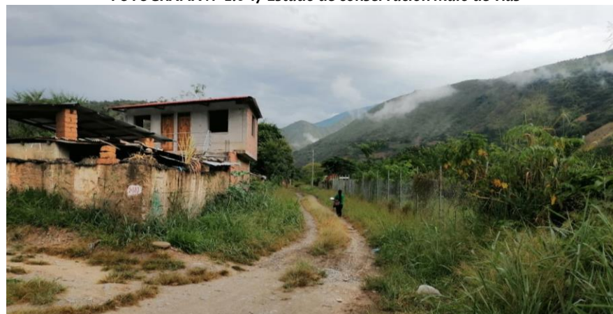
FOTOGRAFIA N° 2.6-17 Estado de conservación Malo de vías
