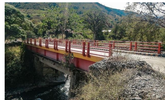
FOTOGRAFIA N° 2.6-57 Paradero formal de Vehículos del Poblado FOTOGRAFIA N° 2.6-58 Puente de Metal de acceso al poblado
