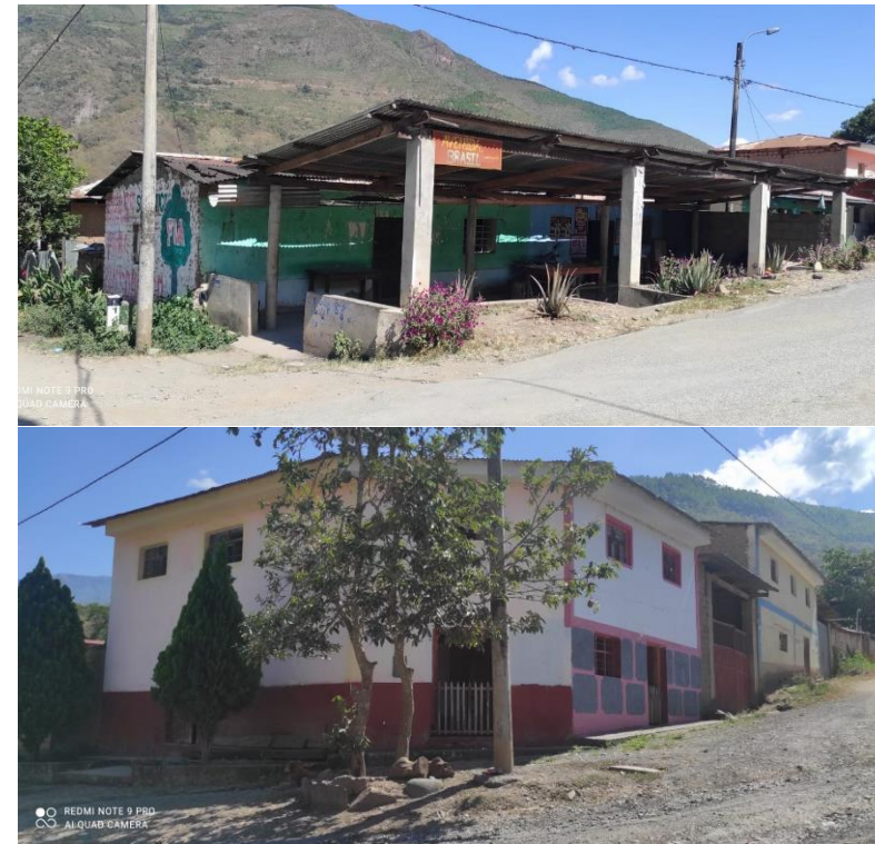
Imagen 1 y 2: Viviendas conformadas múltiples bloques que evidencian crecimiento horizontal, Lote 4 y 7 de la Manzana 3
