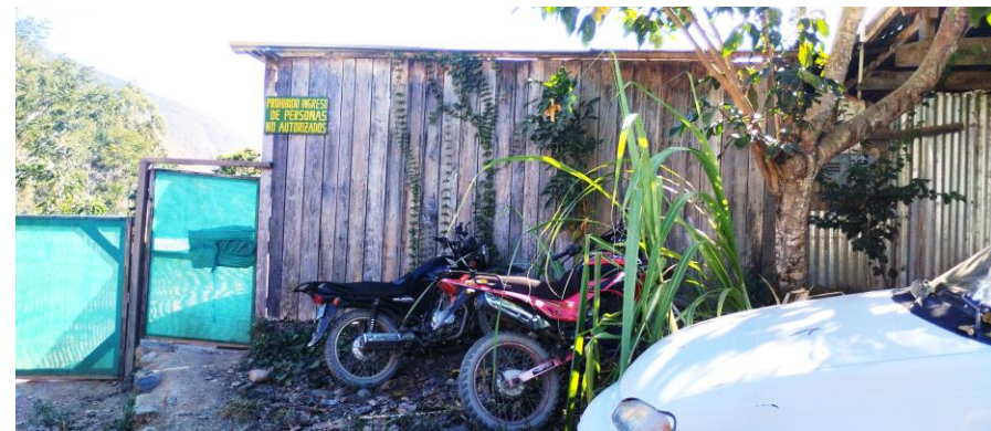
FOTOGRAFIA N° 2.6-18 Edificación de madera
