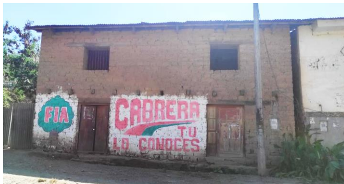
FOTOGRAFIA N° 2.6-16 Edificación de adobe
