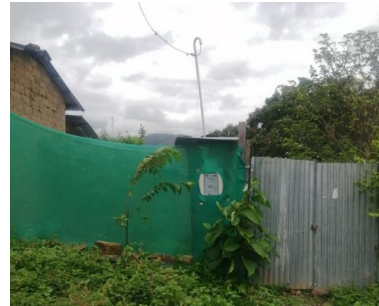
FOTOGRAFIA N° 2.6-56 Acometida domiciliaria - Poste de Alumbrado Público
