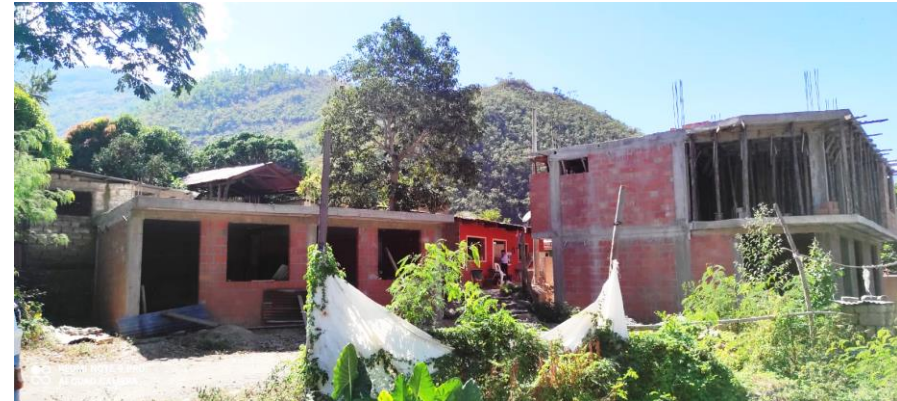
FOTOGRAFIA N° 2.6-17 Edificación de concreto
