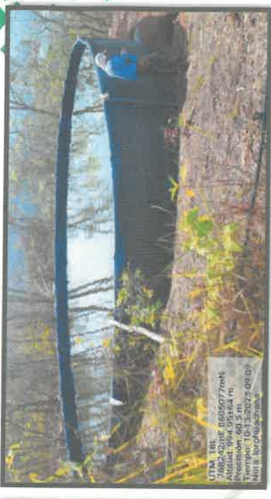
Puesta en funcionamiento de geotanques de 30m 3
