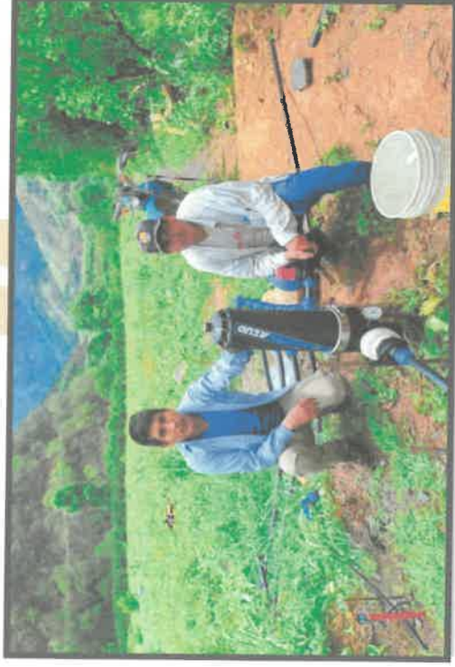
Instalación de riego parcelario con micro aspersores
