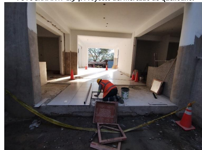
FOTOGRAFÍA N° 2.3-4: Proyecto del Mercado de Quellouno.
