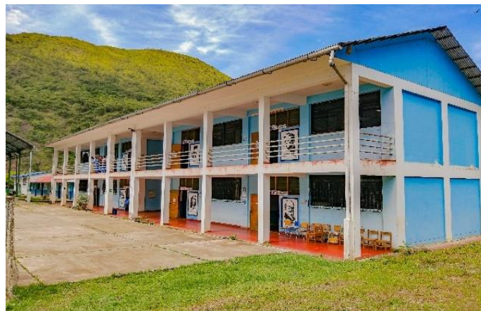
FOTOGRAFÍA N° 2.6-44: Bloque de 2 niveles de aulas Colegio Jose Olaya
