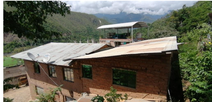
FOTOGRAFÍA N° 2.6-18: Edificación de adobe
