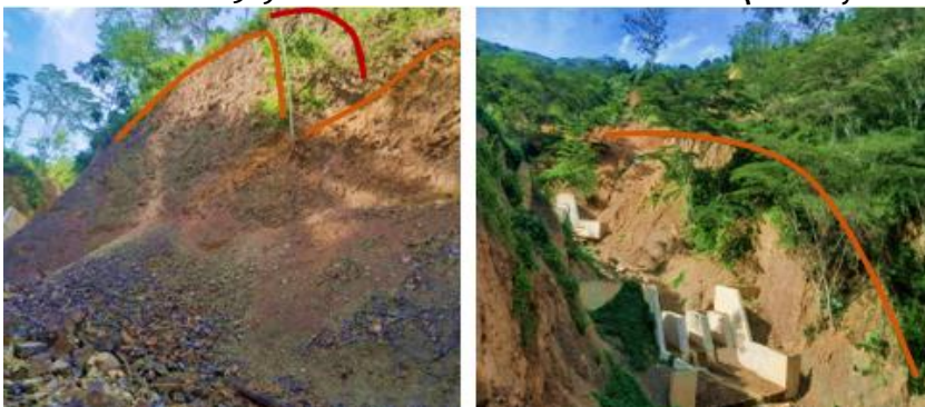
FOTOGRAFÍA N° 2.5-19: Movimientos en masa en el talud del río Quellomayo.
