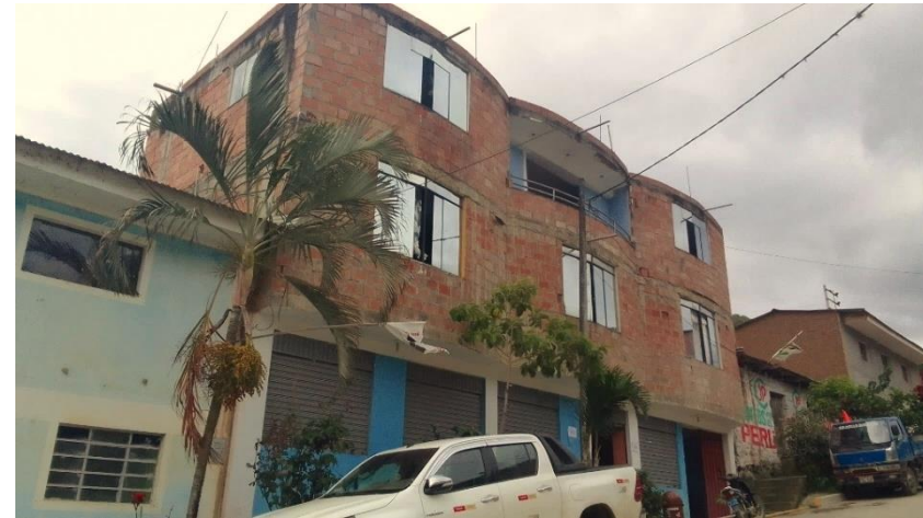
FOTOGRAFÍA N° 2.6-13: Edificaciones de tres, dos y un nivel
