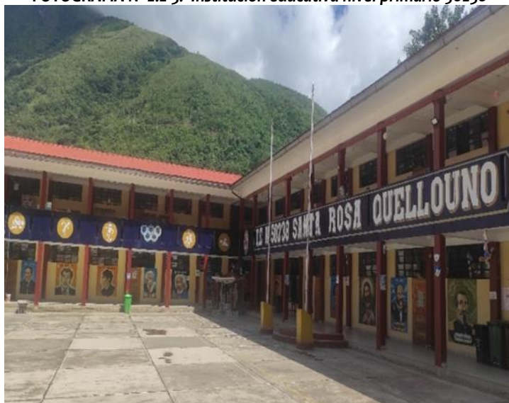
FOTOGRAFÍA N° 2.2-3: Institución educativa nivel primario 50238
