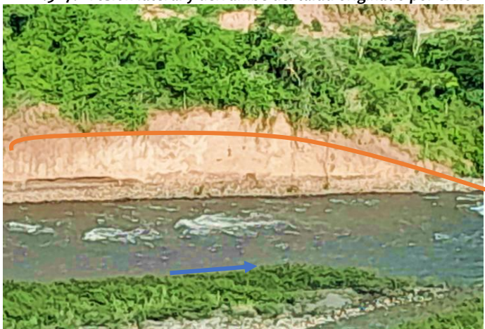
FOTOGRAFÍA N° 2.5-17: Erosión lateral y derrumbe del talud originado por el río Yanatile.
