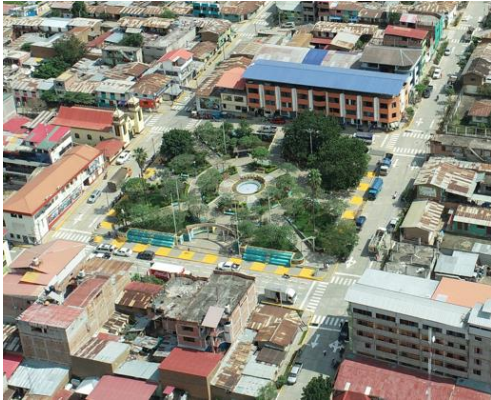
Fotografía 1 6: Plaza Principal del CCPP de Quellouno
