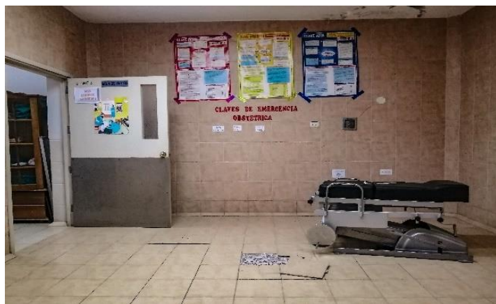
FOTOGRAFÍA N° 2.6-49: Consultorio de Centro de salud Quellouno
