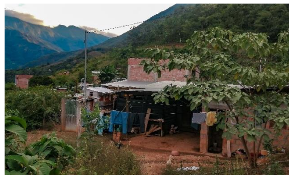
Imagen 1 y 2: Viviendas con distribución por bloques
