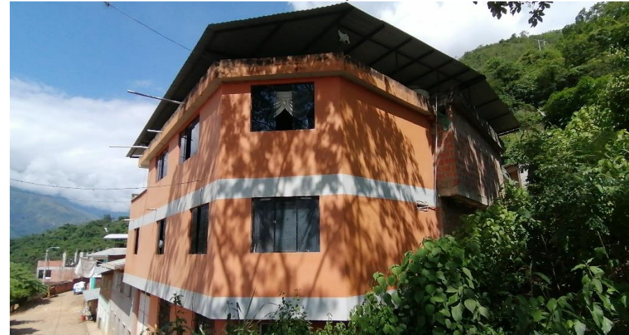
FOTOGRAFÍA N° 2.6-17: Edificación de ladrillo
