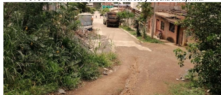
FOTOGRAFÍA N° 2.6-27: Vía de concreto y trocha sin afirmar
