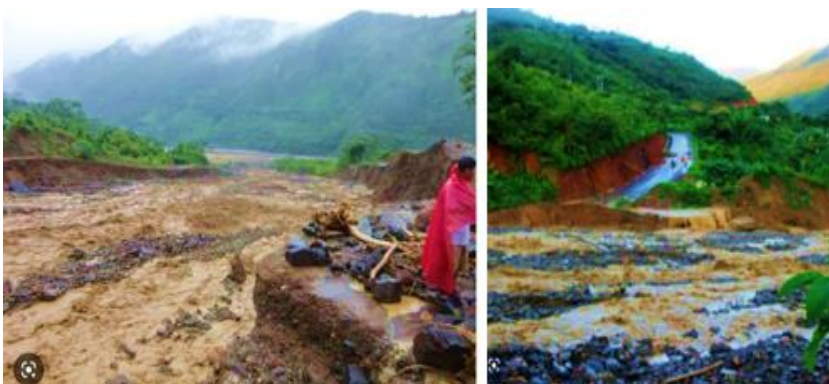
FOTOGRAFÍA N° 2.5-18: Huaycos y erosión lateral originado por el río Quellomayo.
