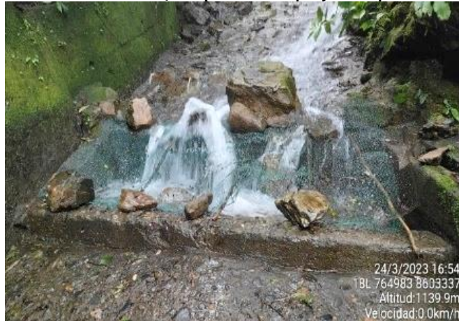
FOTOGRAFÍA N° 2.4-10: Quebrada Pinipiniyoc – Captación
