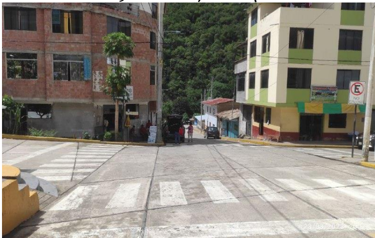
FOTOGRAFÍA N° 2.3-8: Paradero informal de Quellouno
