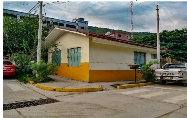
FOTOGRAFÍA N° 2.6-47: Casa Materna Quellouno
