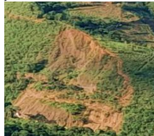
FOTOGRAFÍA N° 2.5-21: Se observa el mismo deslizamiento desde una parte más alta.
