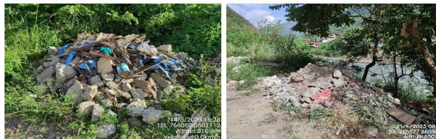
FOTOGRAFÍA N° 2.4-35: Puntos de acumulación de residuos de la construcción y demolición
