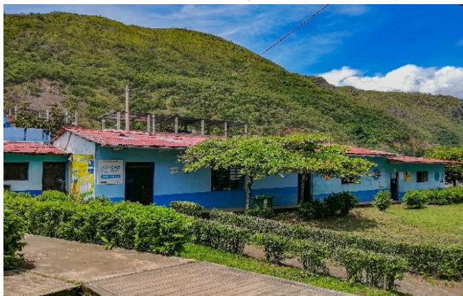
FOTOGRAFÍA N° 2.6-43: Bloques aulas I.E. Jose Olaya
