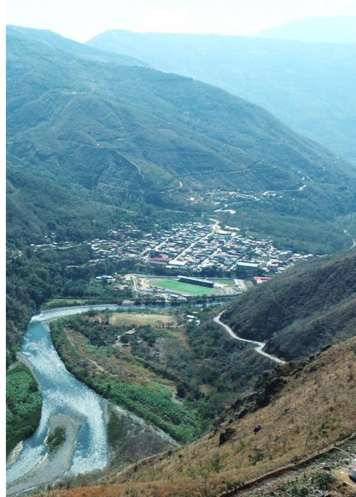
Fotografía 1 8:1 Vista General del CCPP de Quellouno
