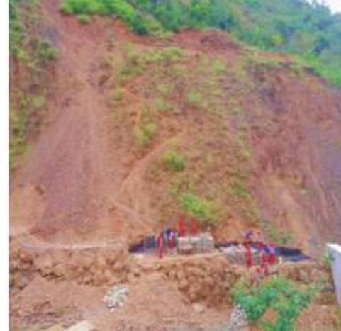
FOTOGRAFÍA N° 2.5-22: Construyendo muros de gaviones en la base del deslizamiento.
