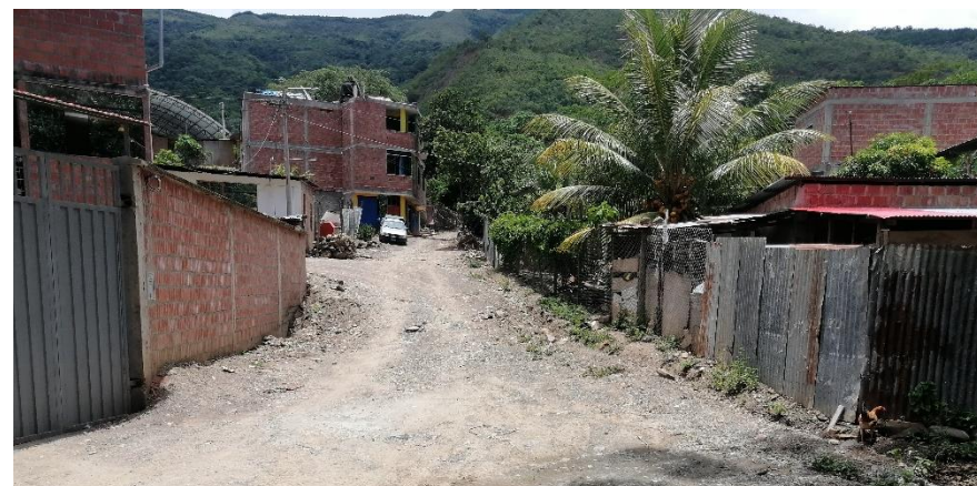
FOTOGRAFÍA N° 2.6-30: Estado de conservación bueno de vías
