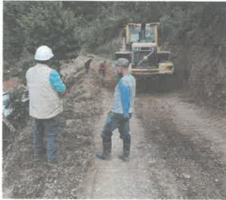
Rehabilitación de accesos a usuarios en toda la cuenca de chirumbia.
