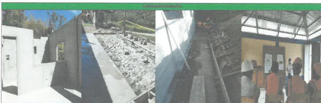
Legenda Se observa el salón comunal en plena ejecución el patio se encuentra lleno (empedrado), para su vaciado. Explicación Se observa el empedrado correspondiente a las veredas al borde del salón comunal. en esta imagen se observa las chafas sobre el plan de seguridad en el trabajo.
