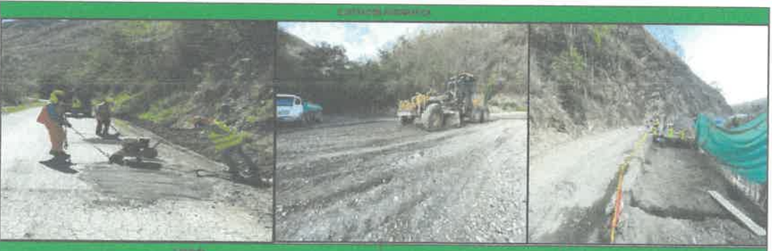
FOTO N°01 TRABAJOS DE PARCHADO CON EMULSION LENTA FOTO N°02 TRABAJOS DE PERFLADO Y COMPACTADO FOTO N°03 TRABAJOS DE EXCAVACION PARA BADEN
