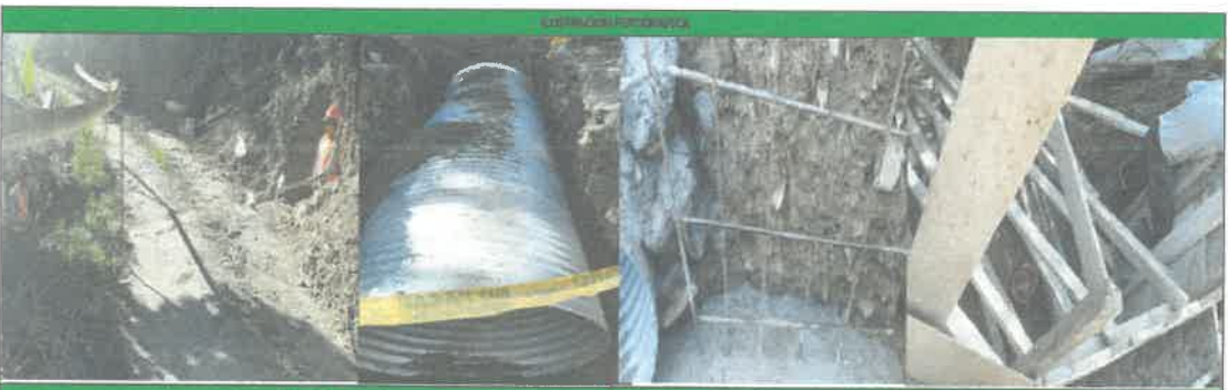
FOTO N°1 SE OBSERVA LA EXCAVACION MANUAL DE ZANJA FOTO N°2 SE OBSERVA LA INSTALACION DE TMC FOTO N°3 SE OBSERVA EL ENCOFRADO PARA EL VACADO
